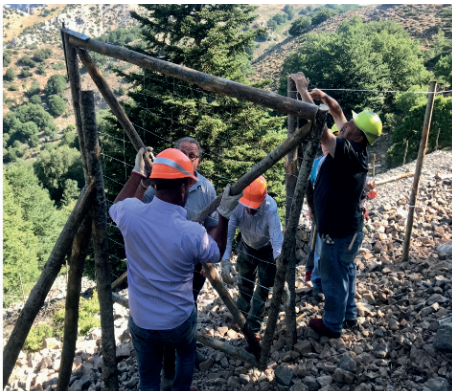
Fig 33. Colocación de la puerta
