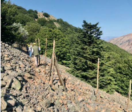
Fig. 34. Installazione delle recinzioni
